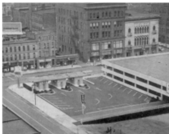
Fig. 11. Parkeringsanlæg i Manhattan, N.Y., U.S.A.
