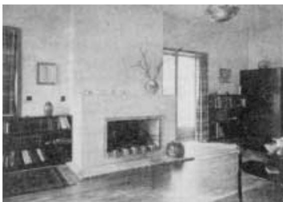
Kamin i Opholdstue, tegnet af Arkitekt Henry Frænkel . Materialer: Pudset; Kaminplade af glittet Beton, isoleret med Asbest; Udmuring og Forplade af ildfaste Sten; hvertandet Skifte i Kaminbunden paa Kant, hvorved dannes en „Rist“. Udvendig Mur bag Skorstenen opført af 2 Halvsten uden Forbandt og med lille Mellemrum.
