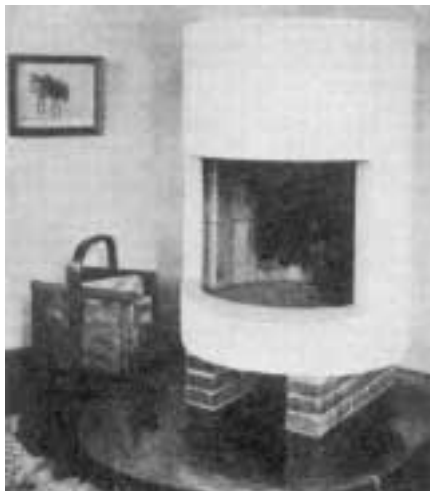
Beton-Kaminovn til Opstilling frit, tegnet af Arkitekt Erhard Lorenz . Konstruktion og Materialer: 2 færdigstøbte Betonrør, Diameter indv. 60 cm, Højde 60 cm og 40 cm. Bunden og Laaget udstøbes, og der faststøbes ildfaste Sten. Paa Sidefladen opsættes ildfaste Sten i ildfast Ler. Kaminen kalkes udvendig. De viste Bukke opmures af 3 Skifter brune Hasleklinter. Kaminen opstilles paa en Kobberplade. Aftræksrør til Skorsten som ved en almindelig Kakkelovn. Pris: Kaminovnen koster færdig opstillet incl. Kobberplade og andre Omkostninger ca. 150 Kr.
