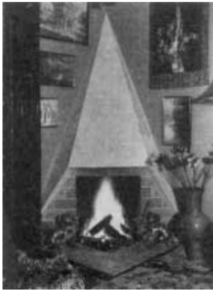
Kamin i Opholdsstue, tegnet af Arkitekt Emil Gjerding . Materialer: Røghætte pudset; Udmuring, Beklædning og Forplade af Hasleklinter.
