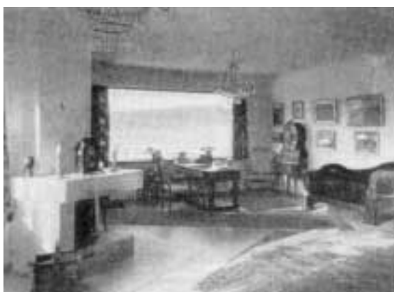
Kamin ved udadgaende Hjørne i Opholdstue, tegnet af Arkitekterne M. L. Stephensen & Knud Thorball . Materialer: Pudset; Kaminplade af Marmor; Bund og Forplade af Klæbersten; Udmuring af ildfaste Sten.
