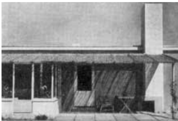
Udvendig Kamin , tegnet af Arkitekterne M. L. Stephensen & Knud Thorball . Aftræk fælles med indvendig Kamin. Materialer: Kaminplade af glittet Jernbeton; Udmuring af ildfaste Sten.
