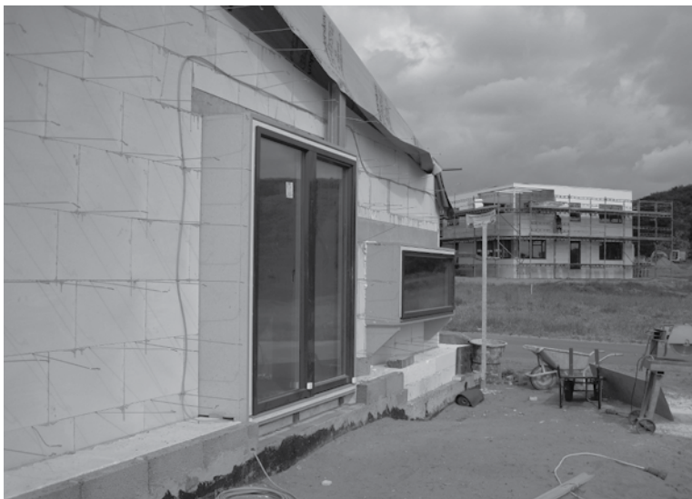
Vinduesløsning med produkt baseret på genbrug af polyuretan. Materialet er lufttæt, isolerende og nemt at bearbejde med almindeligt værktøj.
