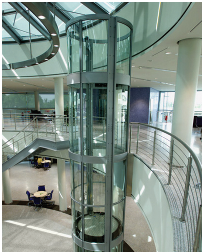
Elevator med skakt i glas og aluminium.
