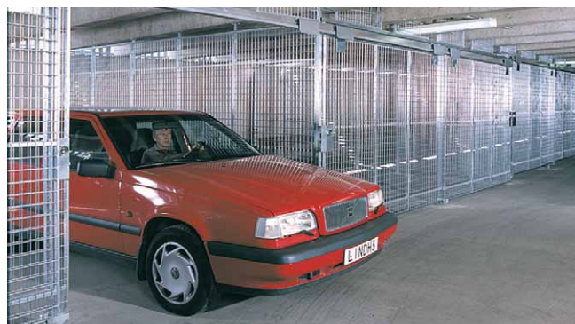
Troax netvægge, type UX 550. Her anvendt til garagevægge.
