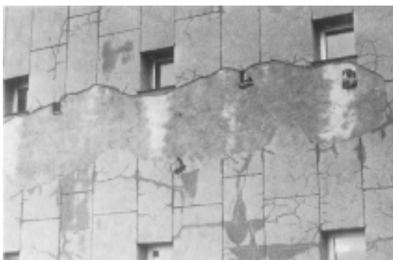
25 Et tæt pudslag stander fugten og frostsprænges.
