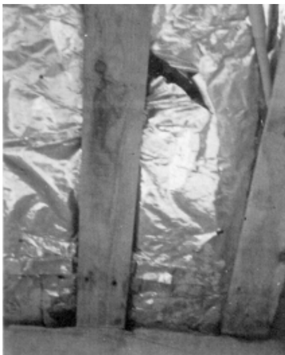
37 Ødelagt dampspærre.
