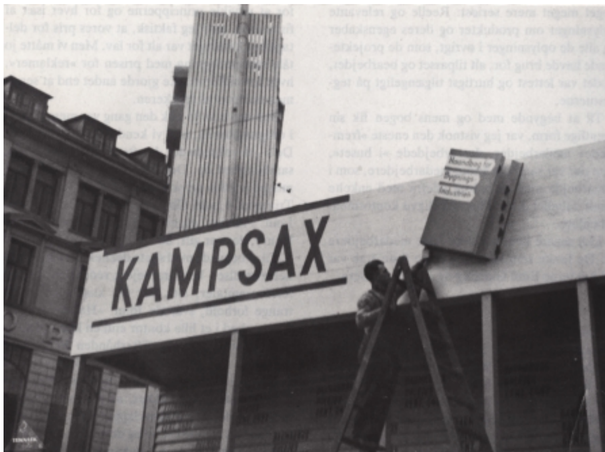
Ved opførelsen af Dagmarhus i 1937–38 blev der opsat en kæmpe HFB på plankeværket.
