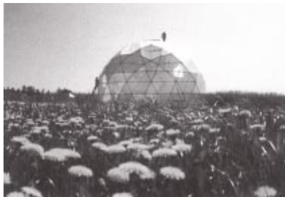
Fig. 8. Dome, Nordvestjysk Folkecenter i Thy En minimal-konstruktion beregnet som væksthuse til intensiv produktion af grøntsager og fiskeopdræt. Opført 1992.
