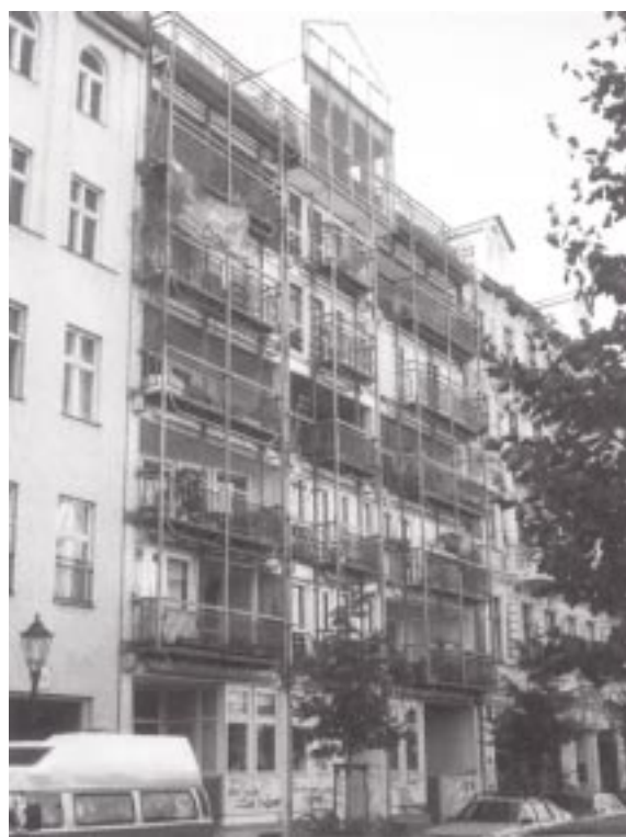
Fig. 5. »Wohnregal«, Admiralstrasse i Berlin. Beboerne har selv udformet individuelle boliger på forberedte betondæk. Opført 1987.
