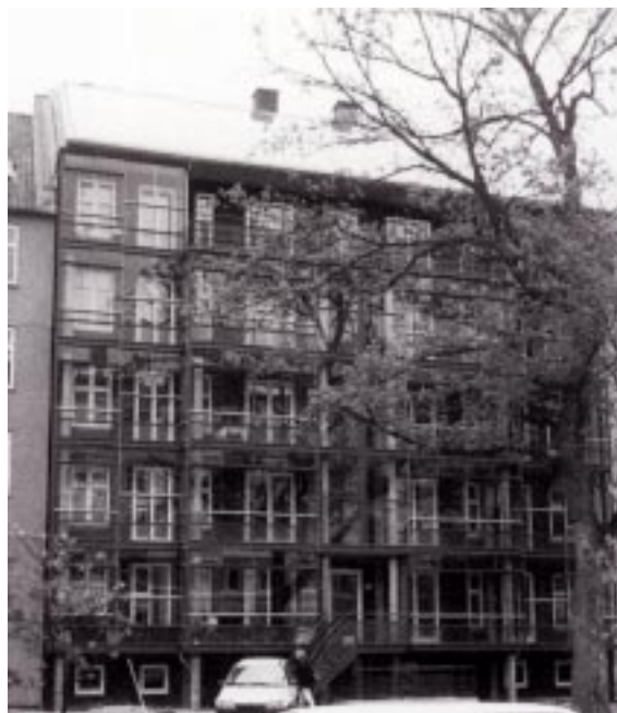
Fig. 9. Renoveret ejendom Dannebrogsgade 18, København. Et fremragende eksempel på en ny glasfacade smukt tilpasset bygningen. På taget solfangere. Gennemført 1991-92 (Ark.: Boje Lundgaard & Lene Tranberg).
