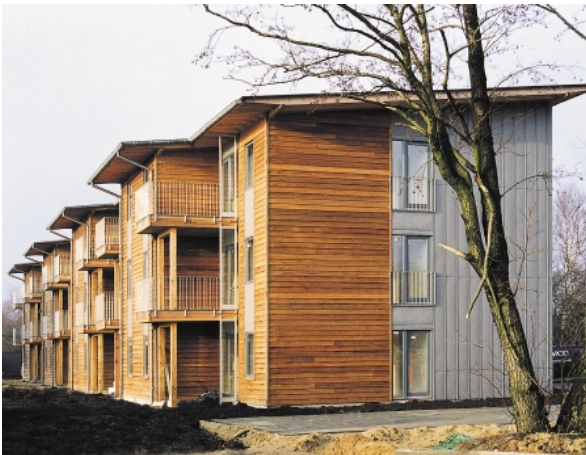
Figur 1. CASA NOVA byggesystem, 72 boliger på Thrigesvej i Herning.
