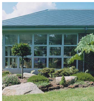
Cembrit sortblå 40 x 40 skifer. Parcelhus og erhverv, Helmholt Elektronik, Struer. Arkitekt: FN-Tegnestuen A/S
